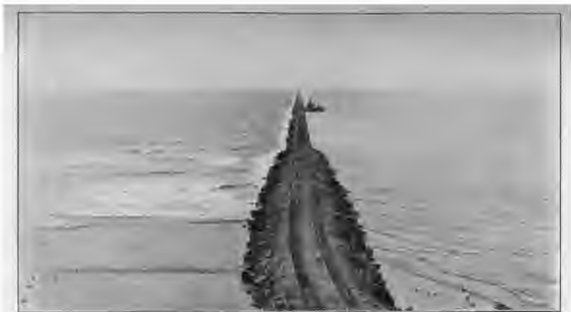
ÉTABLISSEMENT D'UN BRISE-LAMES A TORO-POINT, A UNE DES ENTRÉES DU CANAL
